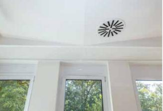
TROCKENBAU. Im Dachgeschoss waren Vorsatzschalen und extreme Deckenverschneidungen unter dem gewölbten Bestandsdach eine besondere Aufgabenstellung.
